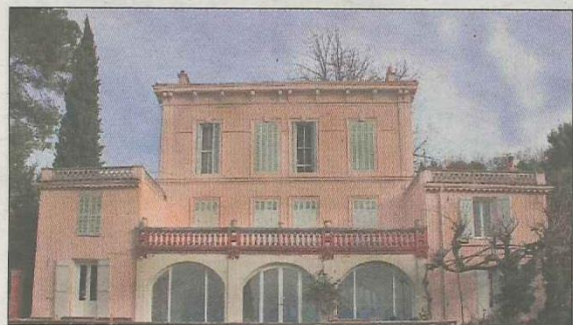
Sur cette propriété à Draguignan, vingt logements sociaux et vingt logements en pension de famille vont être créés. (Photo DR)
